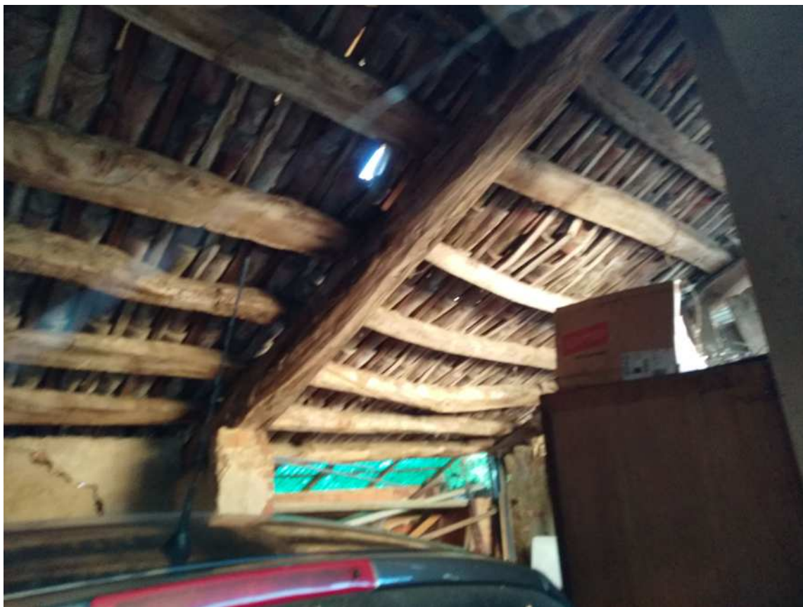
Bassi fabbricati ala sud: particolare dello stato di conservazione di muratura sud e copertura
